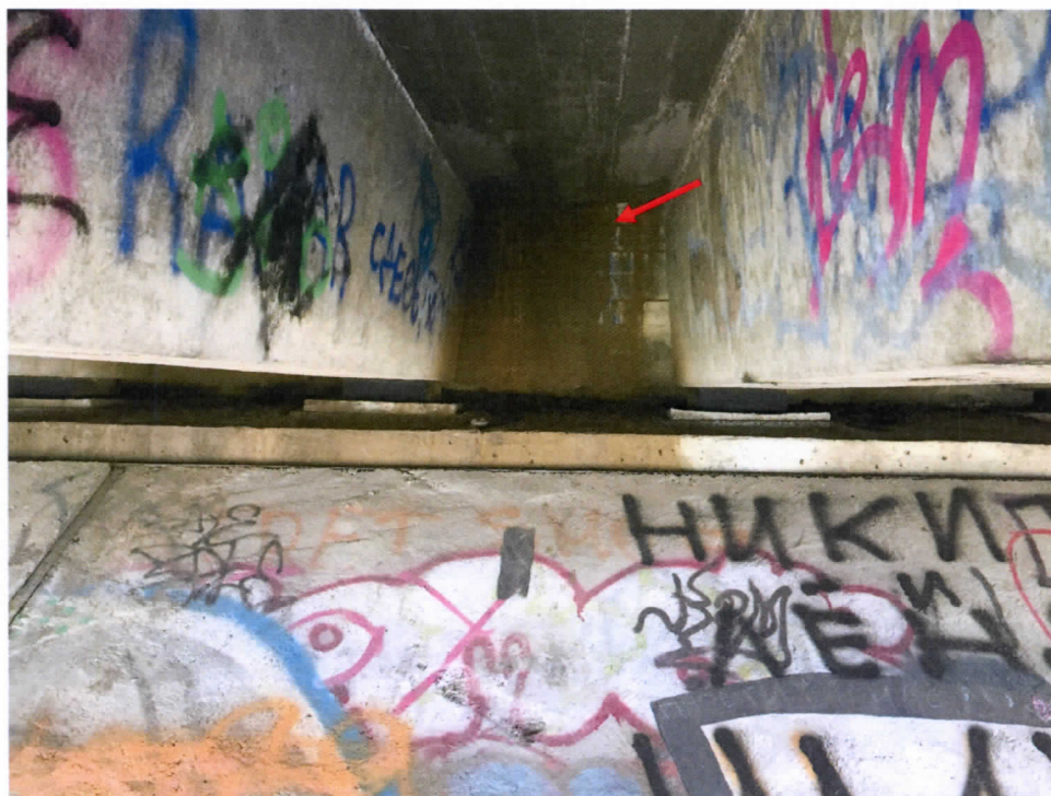
5.att. Caur deformācijas šuvi uz krasta balstu Nr.5 tek ūdens.
