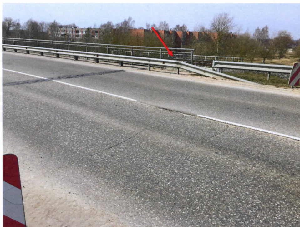
18.att. Sametinātas margas barjeras. Skats pie krasta balsta Nr.1, Rīgas pusē
