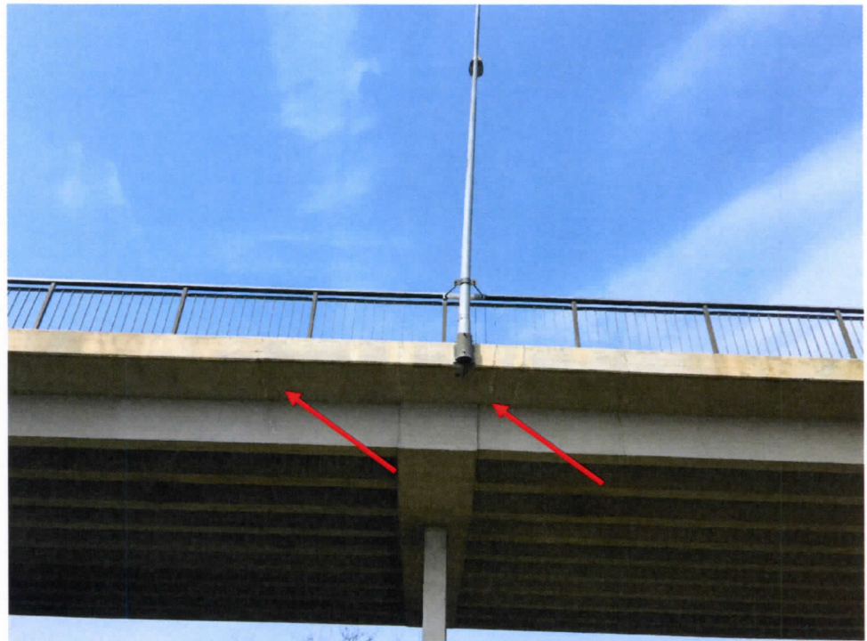
12.att. Plaisas ietves konsolē. Skats pie starpbalsta Nr. 3 centra pusē.
