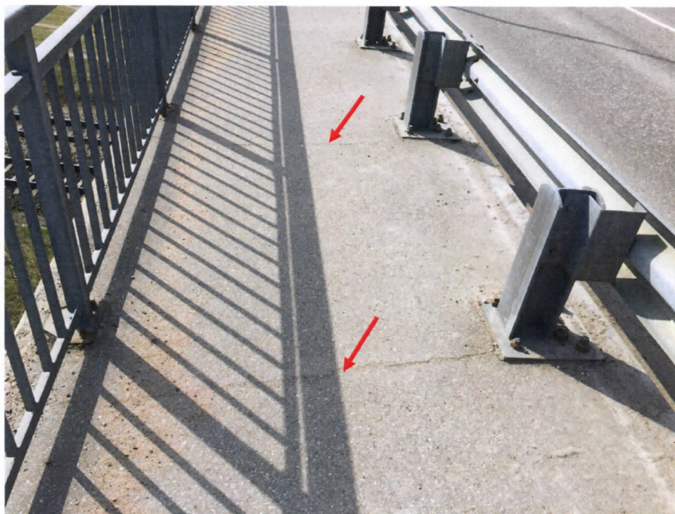
13.att. Nolietojies ietves asfaltbetona segums, plaisas. Skats centra pusē.
