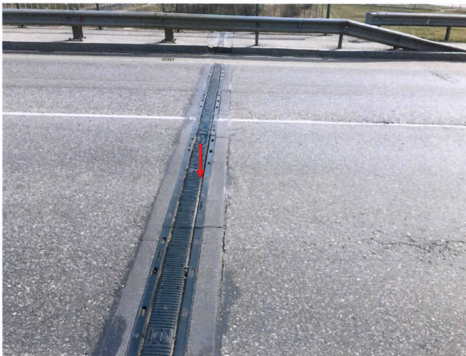
3.att. Salūzusi deformācijas šuve virs krasta balsta Nr.5.
