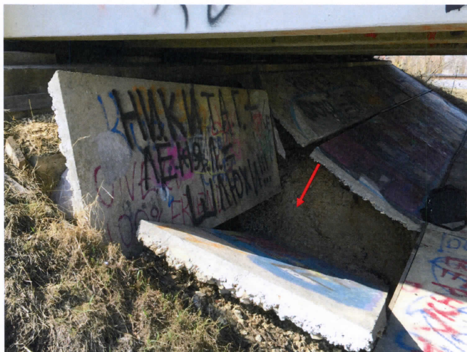
24.att. Izskalots uzbērums un iebrucis konusa nostiprinājums. Skats pie krasta balsta Nr.5 centra pusē.
