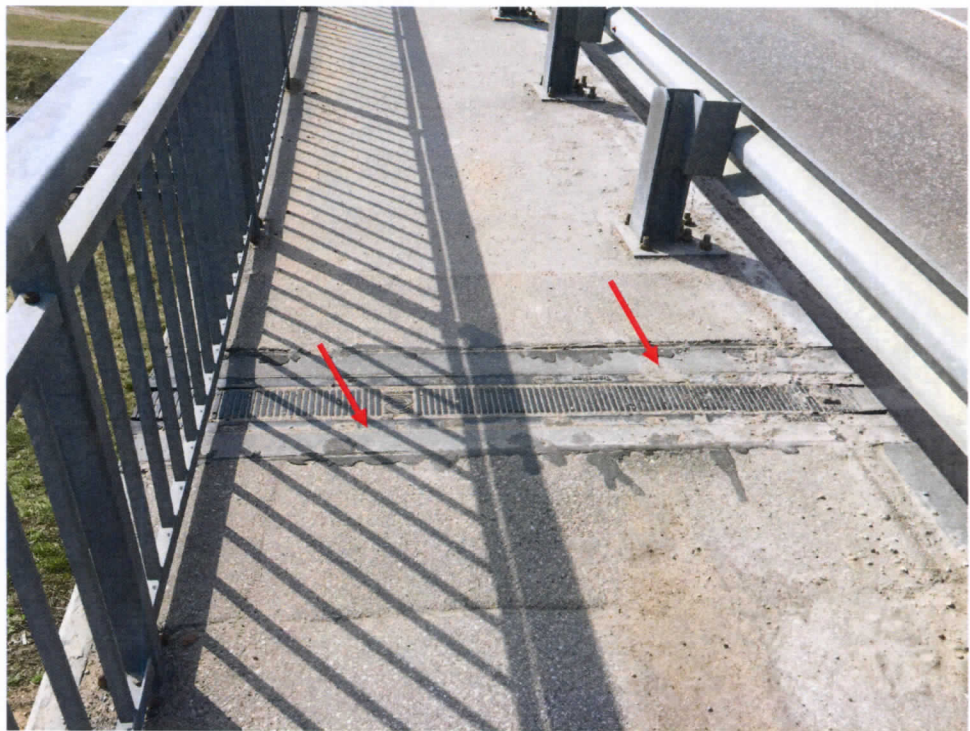
7.att. Bojāta deformācijas šuve ietves daļā virs krasta balsta Nr.1.
