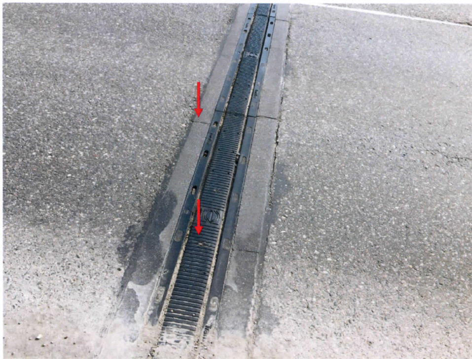
4.att. Salūzusi deformācijas šuve virs krasta balsta Nr.5.
