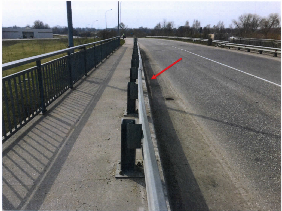
19.att. Mehāniski bojātas barjeras. Skats 3.laidumā centra pusē.
