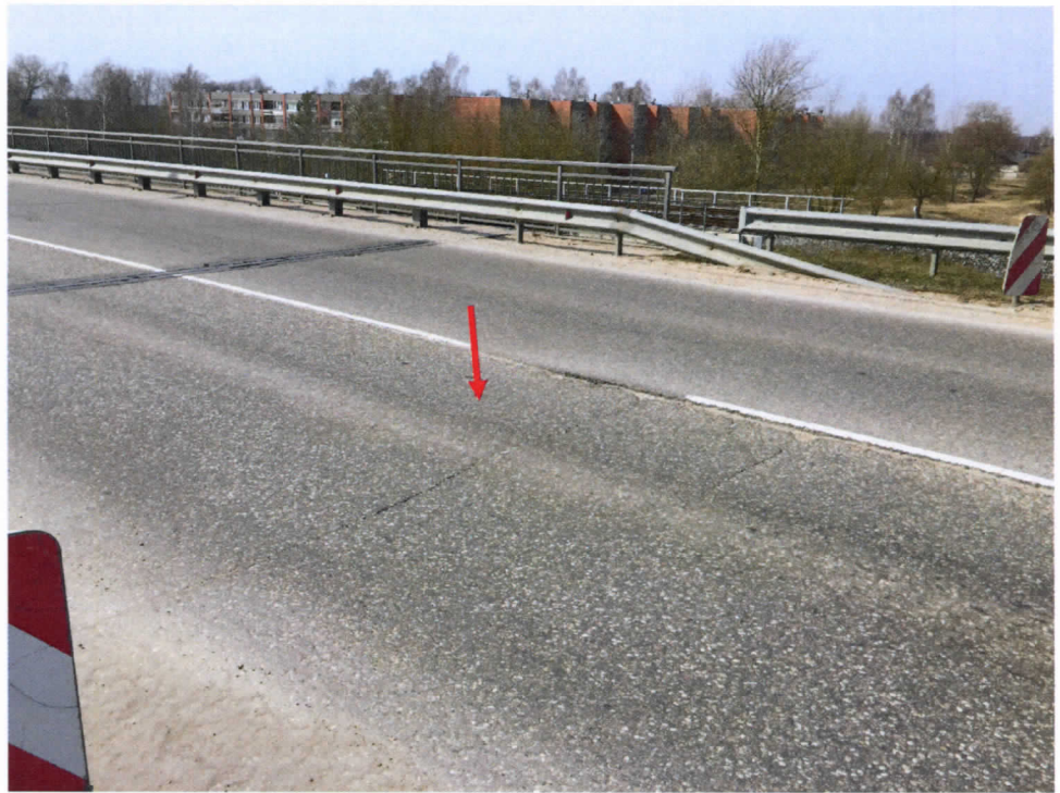
11.att. Sabrucis asfaltbetona segums pieejā. Skats pie krasta balsta Nr.1.
