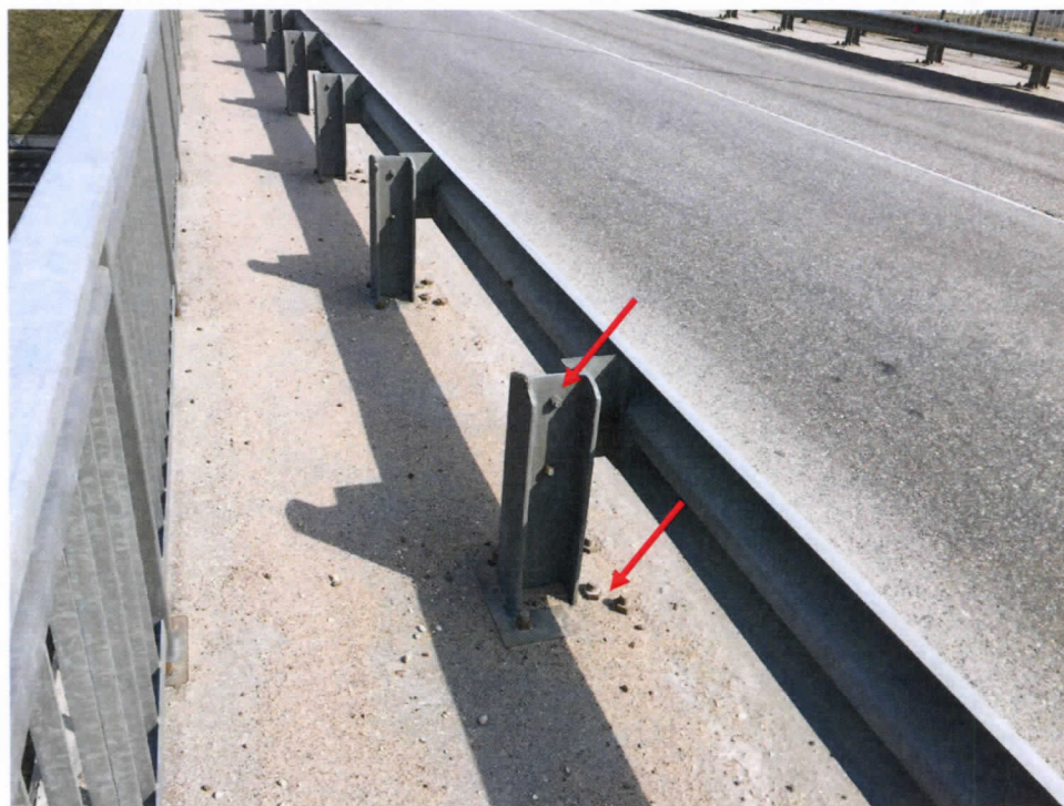
16.att. Skrūvju korozija barjeru stabiņam. Skats Rīgas pusē.
