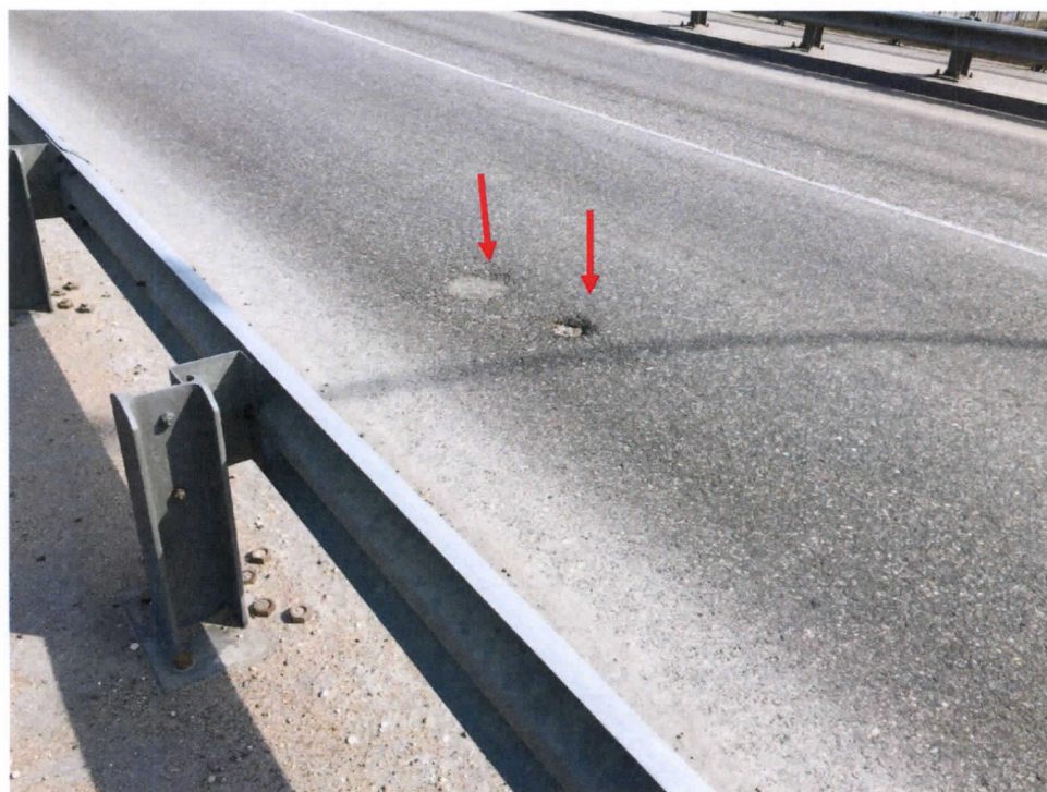
10.att. Nolietojies asfaltbetona segums, veidojas bedres. Skats 2.laidumā
