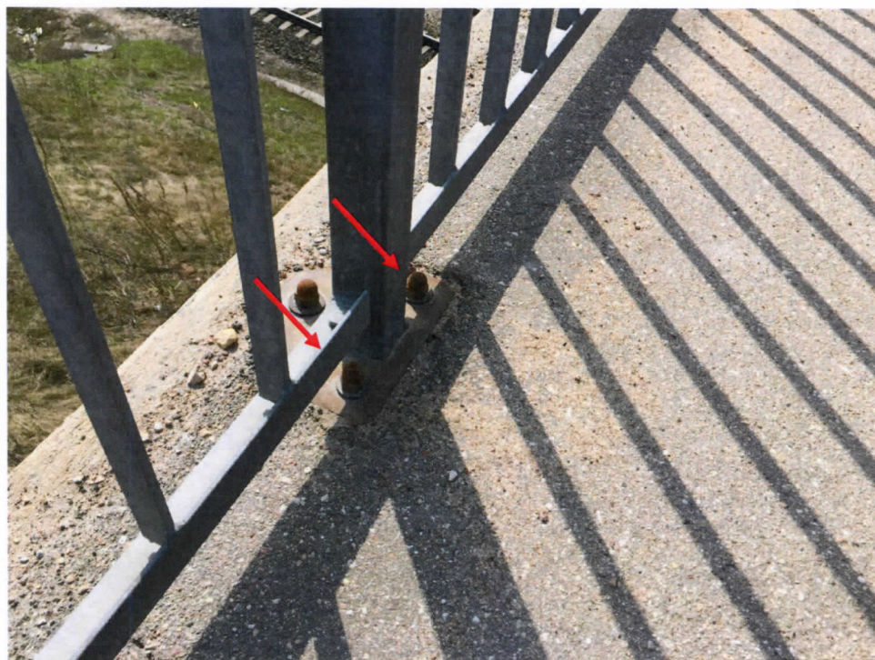
14.att. Uzgriežņu korozija margu stabiņam pie pamatnes. Skats centra pusē.
