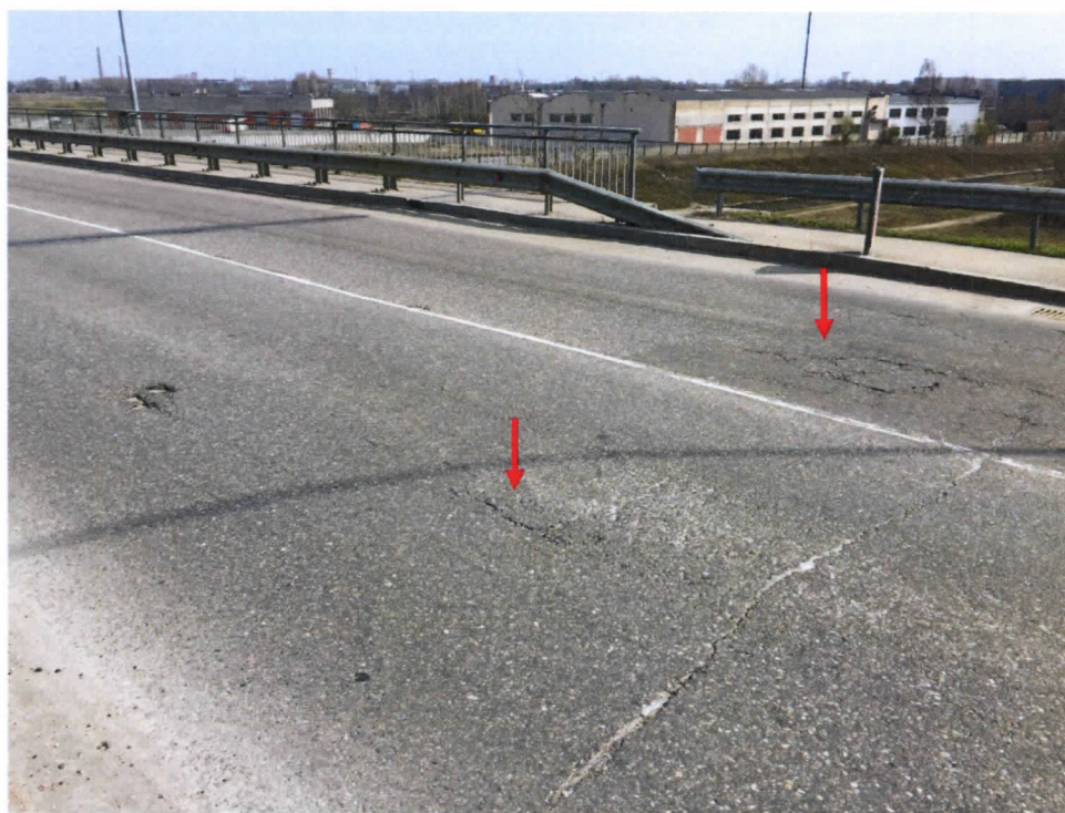
9.att. Sabrucis asfaltbetona segums pieejā. Skats pie krasta balsta Nr.5.
