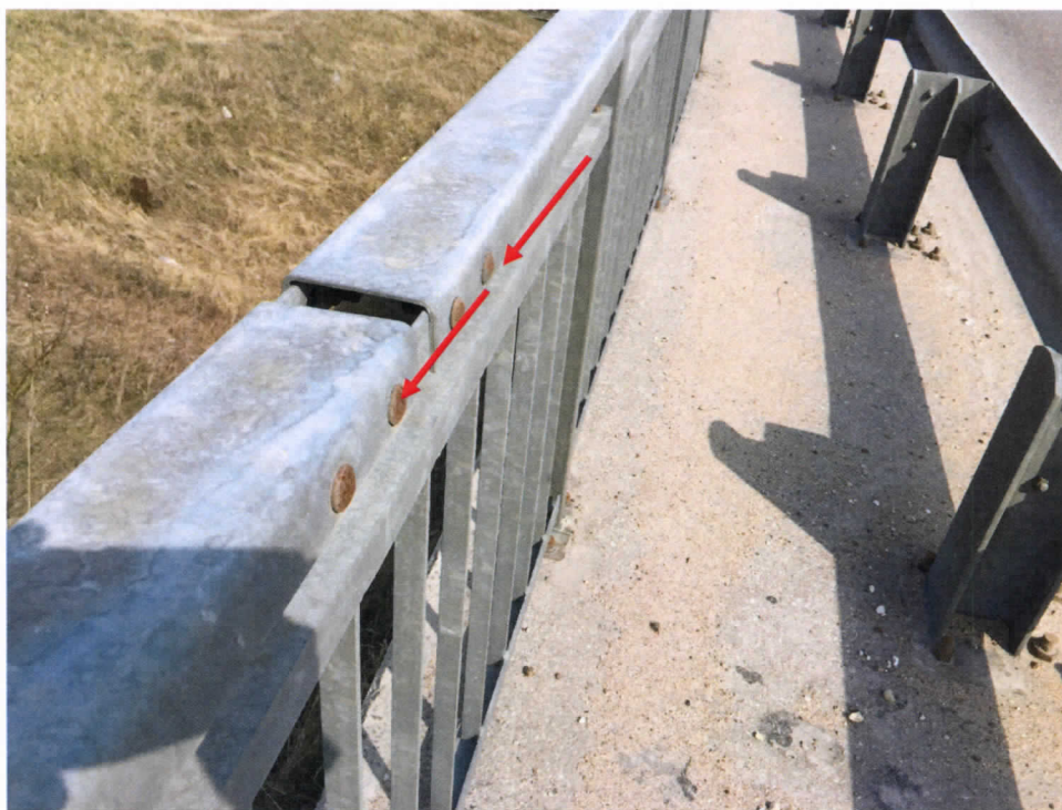
15.att. Skrūvju korozija margu rokturim. Skats Rīgas pusē.
