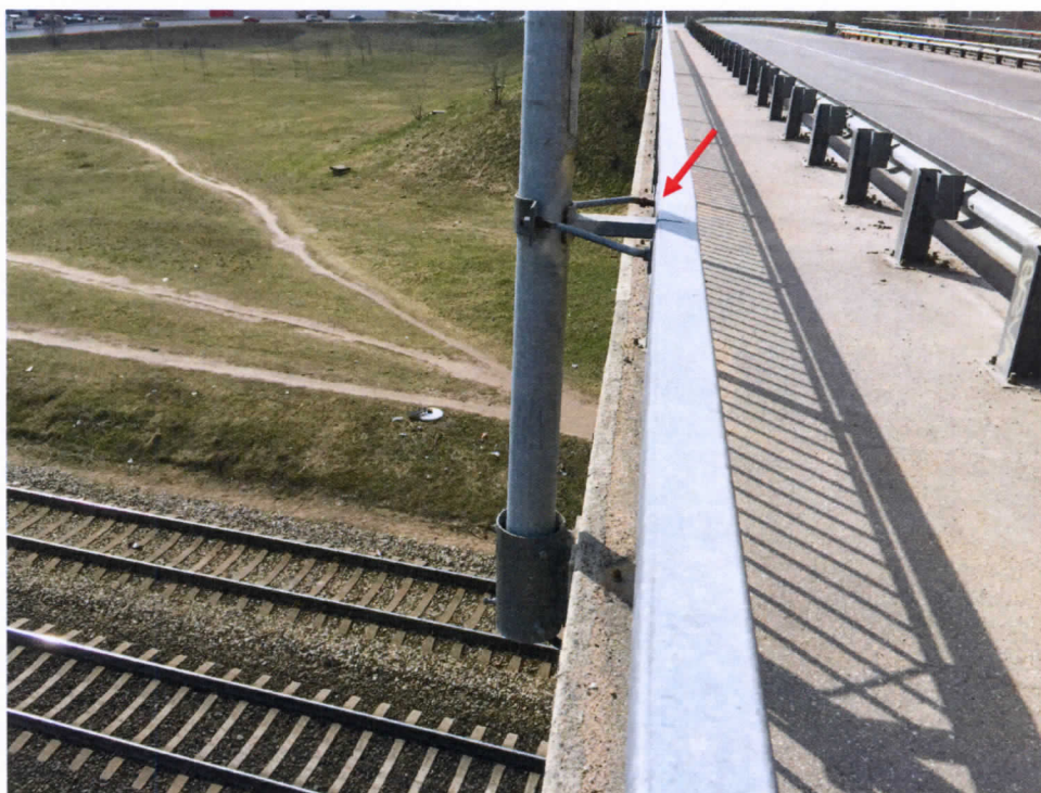
17.att. Bojāts apgaismes staba stiprinājums. Skats centra pusē 2.laidumā
