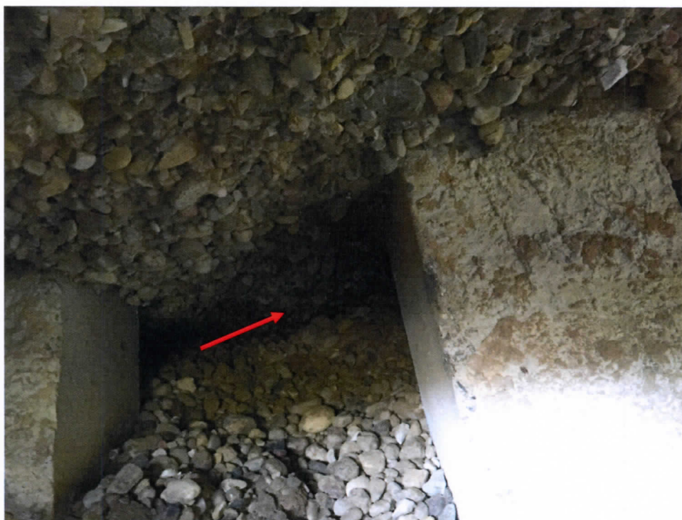
25.att. Tukšums zem uzkalas. Skats pie krasta balsta Nr.5 centra pusē.
